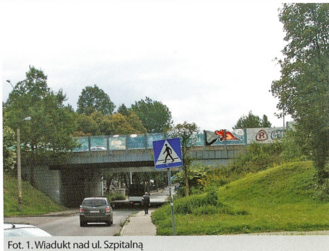
Fot. 1. Wiadukt nad ul. Szpitalną
